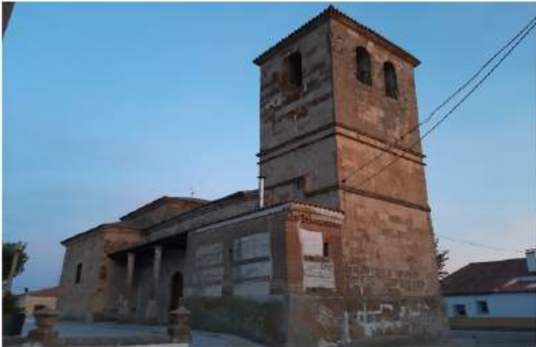
La iglesia de Parada de Rubiales restaurada. En primer plano el cuarto de la torre levantado en 1804 como apoyo a la torre que amenazaba ruina. También se aprecian los salientes de piedras en ambos cruceros, y la primera cornisa de la torre, muestras de una obra inacabada.
